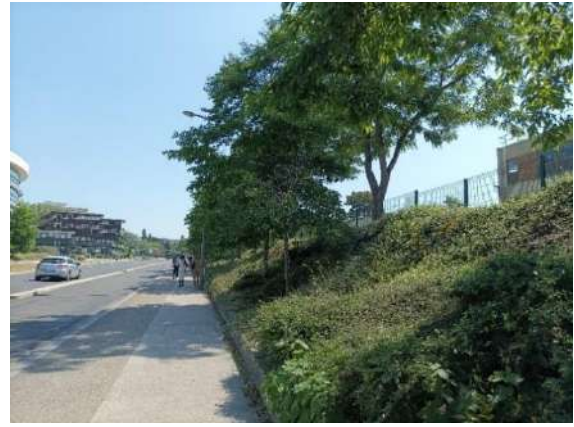
8 - TALUS SUR LE BOULEVARD DE L'HAUTIL
