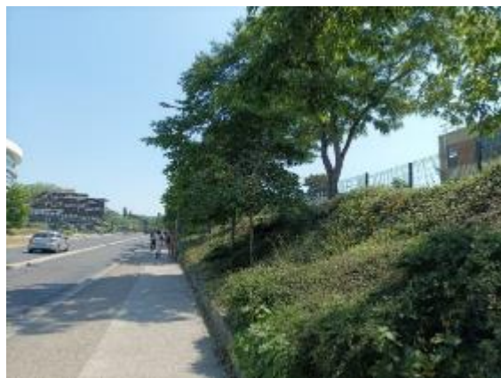
8 - TALUS SUR LE BOULEVARD DE L'HAUTIL
