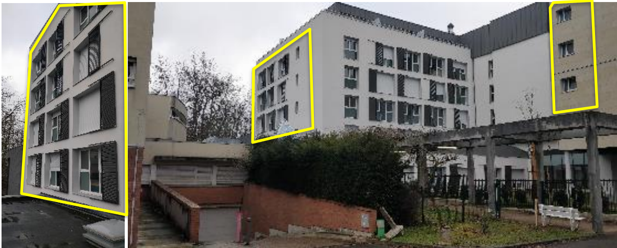
Vue des façades en vis-à-vis de la parcelle projet
