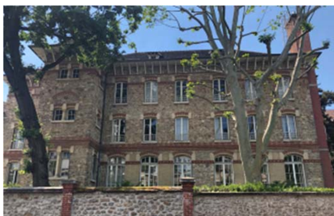
Bâtiment C vu depuis la rue Pasteur
