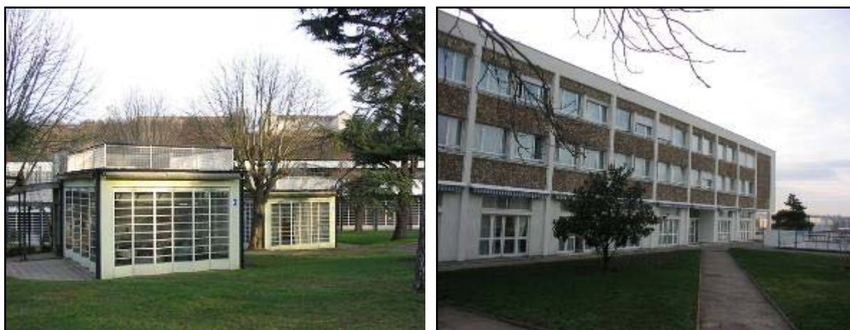
Locaux actuels de l'INSHEA : Pavillons de l'école de plein air, Bâtiment A de l'ancien CNEPA
