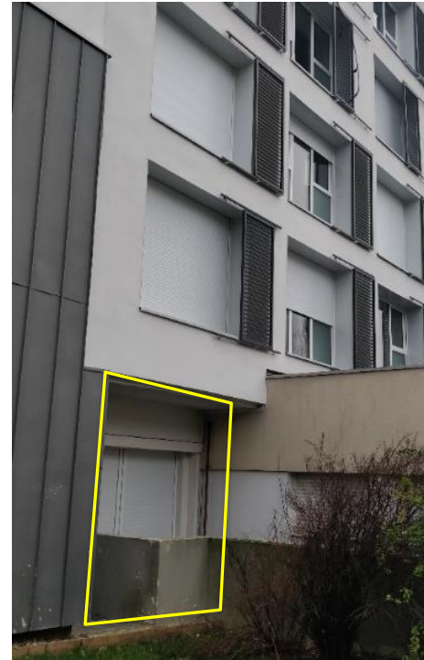
Vue du local du RDC DOMNIS
