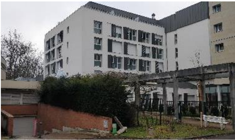
Vue depuis le site PNEI vers la résidence DOMNIS
