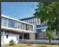
Site des Chênes Cergy (95)
