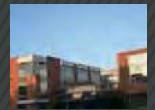
Site du Parc Cergy (95)
